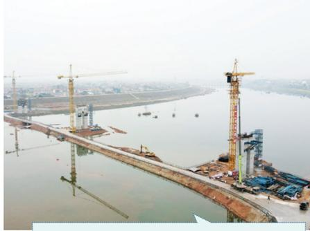
03 3月3日，石澧航道桥梁工程青山澧水特大桥主墩墩身施工全部完成，项目将全面进入上部结构施工阶段。
