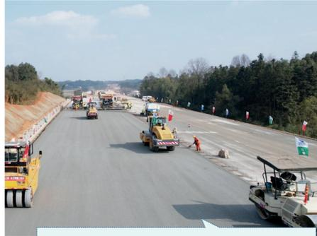
02 3月2日，益常高速扩容五标下基层试验路完成，项目下基层施工正式拉开序幕。
