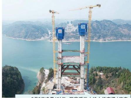
04 3月9日凌晨1时许，洞庭沱水特大桥南塔（官庄侧）左幅塔柱施工突破100米大关，大桥主塔正式进入百米超高空全新施工阶段。
