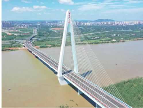
EPC项目，总投资27.1亿元，为长沙市第十四座过江通道，被誉为“湘江之钻”，项目位于长沙市望城区，为双向六车道城市主干路，设计时速60千米每小时，大桥主线长3.24公里，主跨达到300米，采用连续刚构桥梁设计，主塔高202米，是目前湘江上跨度最大、主塔最高的独塔斜拉桥，可容纳3000吨级船舶通航，是湘江流域首座按I级航道标准设计的桥梁。
