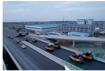
11月13日，经过夜以继日的连续奋战，零陵路面一标主线最后一段沥青上面层完成摊铺，主线沥青路面施工任务完成。
