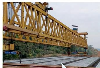
11月20日，随着K6+771新屋大桥最后一块30米箱梁的成功落梁，岳阳荆南项目唯一控制性工程——新屋大桥箱梁吊装任务圆满完成，成为全线首个完成梁板架设桥梁。
